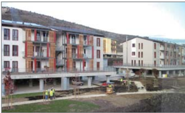
Sito in costruzione/Dwelling site in construction
